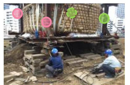
写真⑦ ジャッキダウン状況
