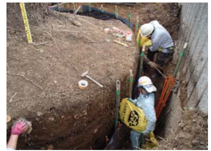
写真② 根回し工
