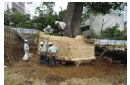
写真④ 根巻状況
