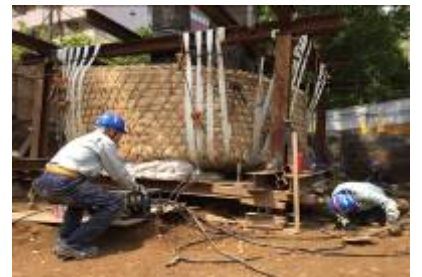
写真⑤ ジャッキアップ状況
