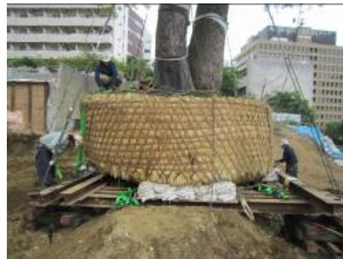
写真⑧ 支柱施工状況
