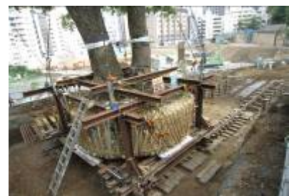
写真⑥ 立曳工
