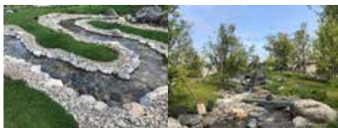
曲水部目地表面に川砂を撒いた様子 ながれ部の外部施設との遮断状況
