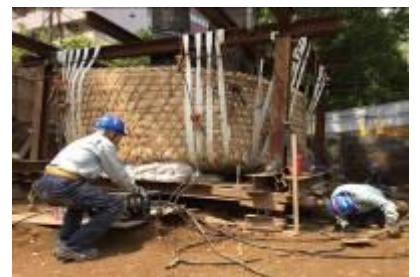
写真⑤ ジャッキアップ状況
