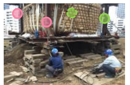
写真⑦ ジャッキダウン状況
