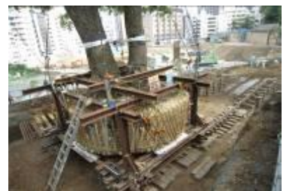
写真⑥ 立曳工
