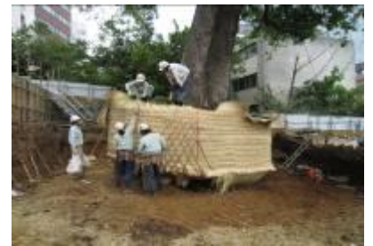
写真④ 根巻状況
