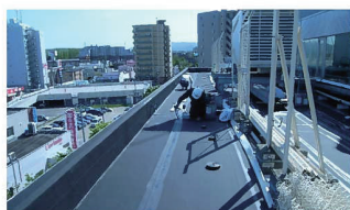
全面ゴムシート防水
