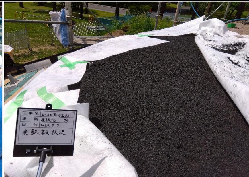
リサイクル材を使った浄化層(炭)による雨水の水質改善
