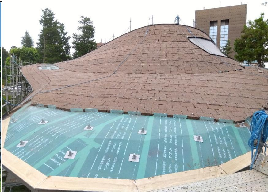
最大40度の急勾配に対応し、固化緑化基盤(エクセルソイル)を補強材で固定
