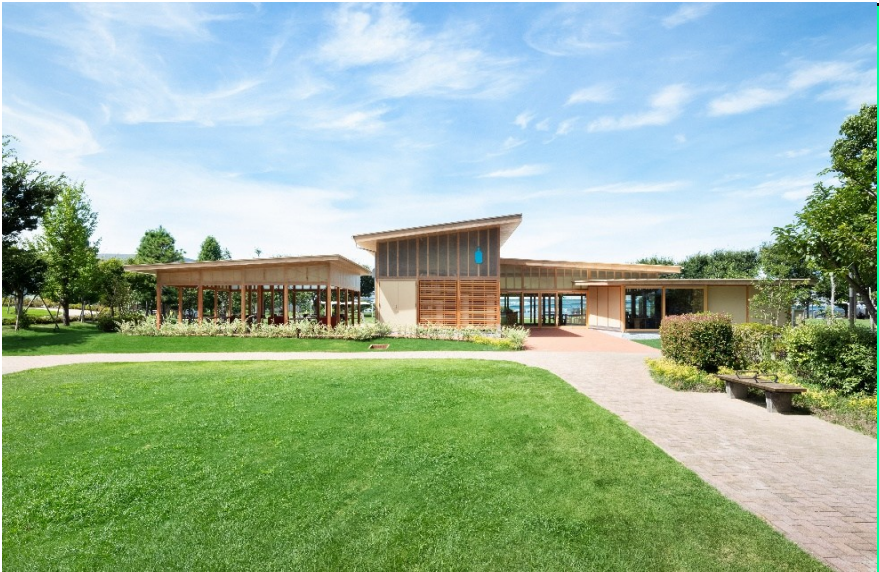
写真1 カフェエントランス側全景
