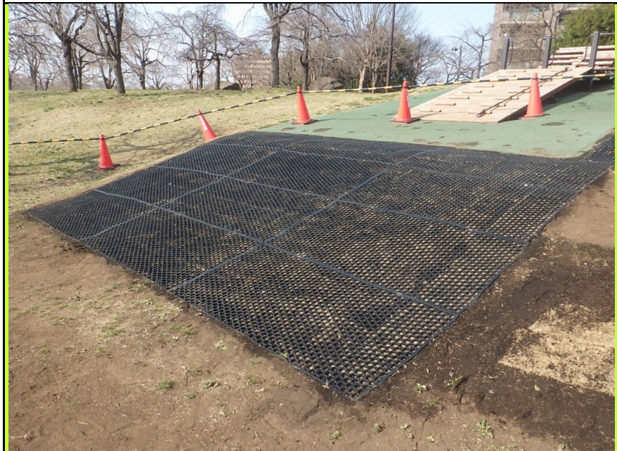
写真3 (削れた部分に客土をし、芝を張り保護マットを設置して滑らかになった斜面)
