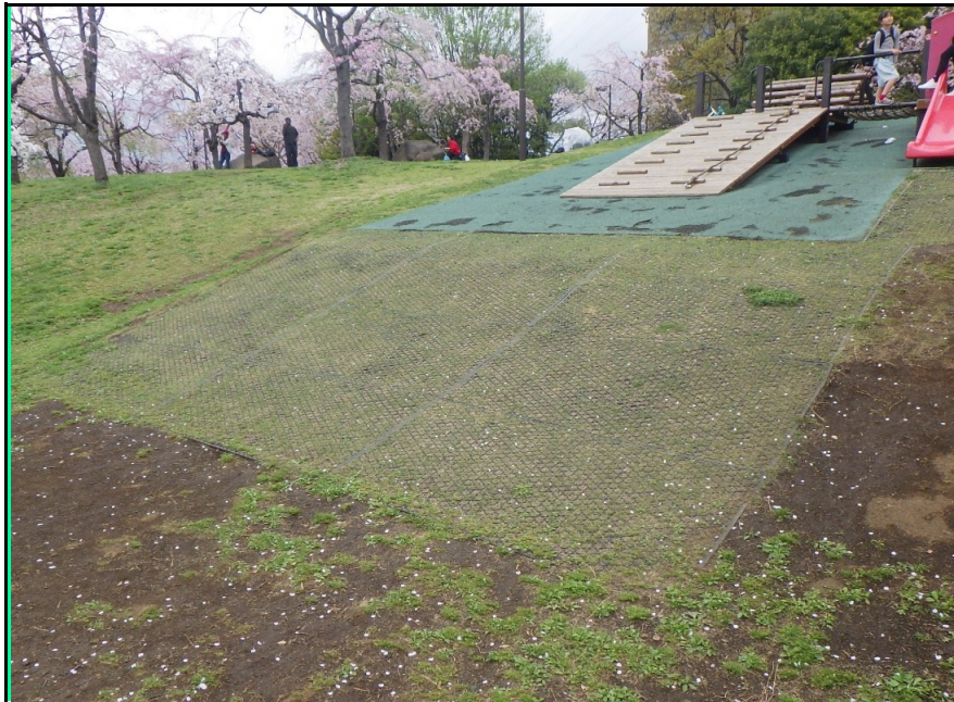
写真1 (施工後1年経過、2024年6月)
