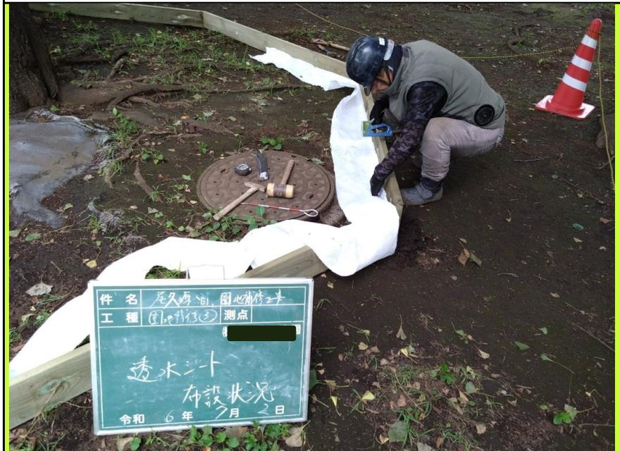
写真3 (矢板を直径4mほどに組み透水シートで土砂の流出を防ぐ)
