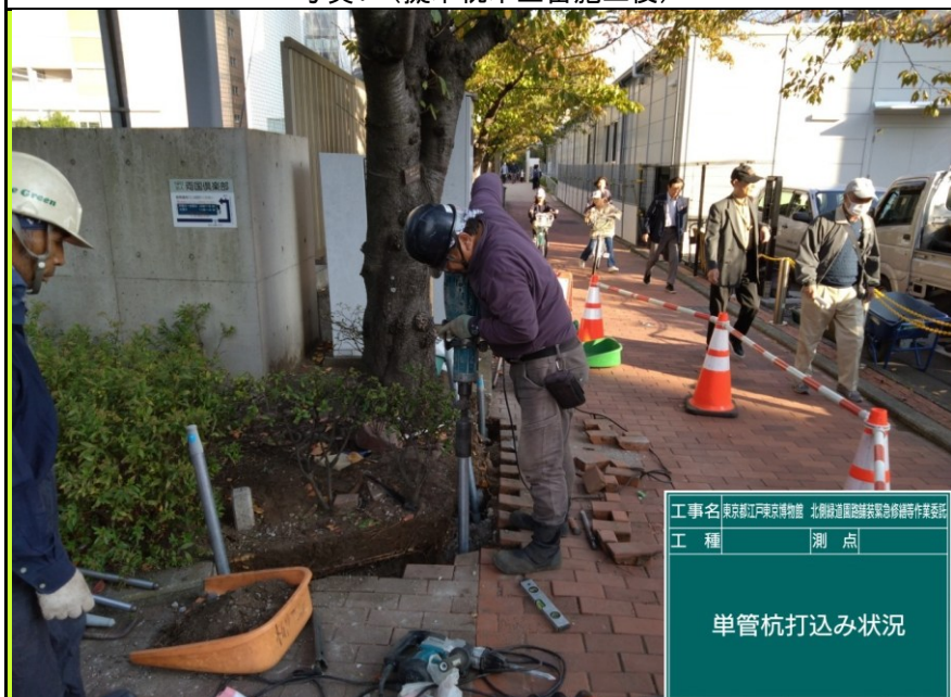
写真3 (土留め固定用の単管打込み状況)
