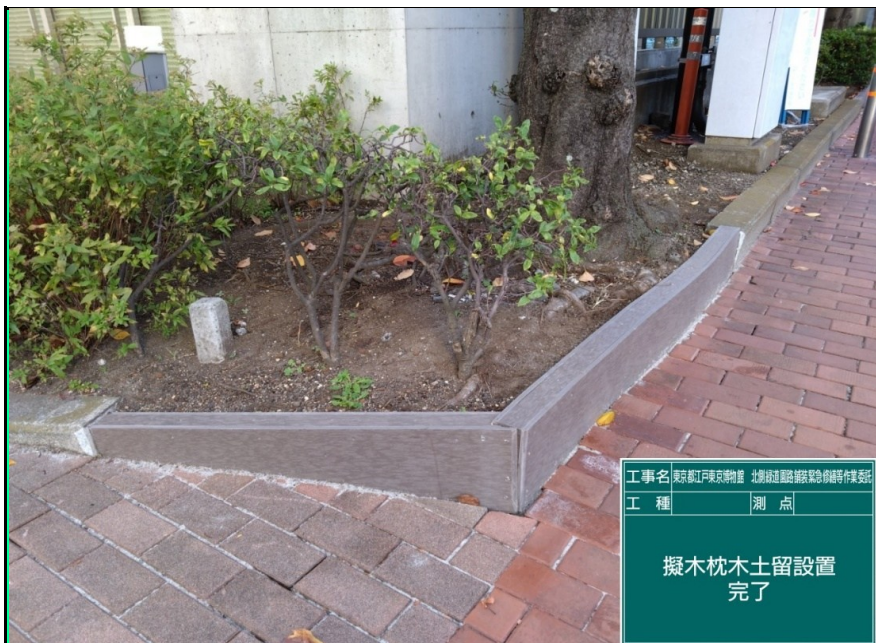
写真1 (擬木枕木土留施工後)
