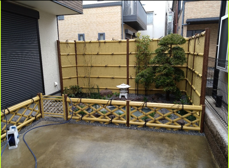
写真4（作業後の全景）
