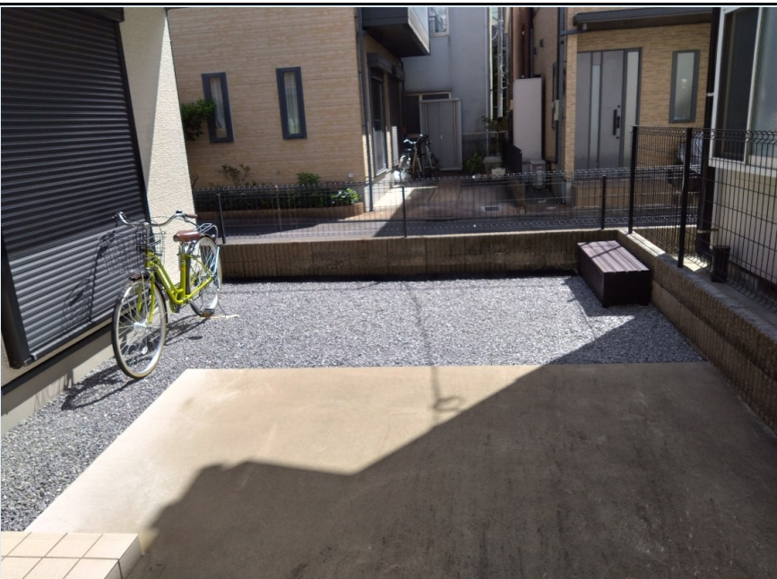
写真2（作業前の全景）
