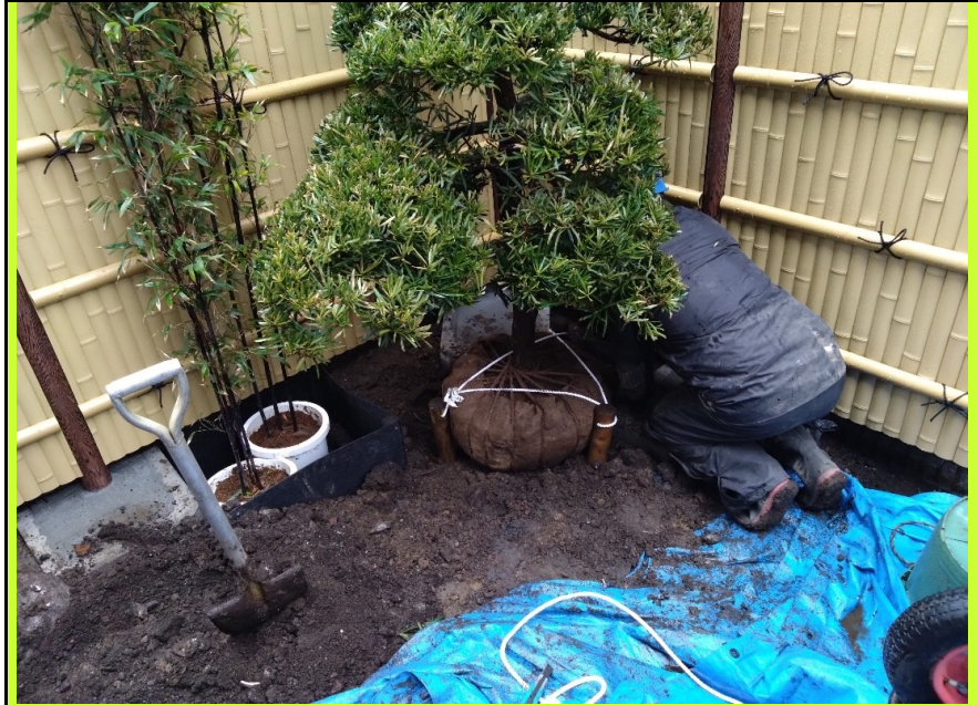
写真3（池や垣根フェンス際のため地下支柱とした）
