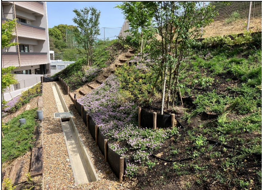
写真3（法面に花木を植栽するため、土壌内部に浸食制御材を設置）
