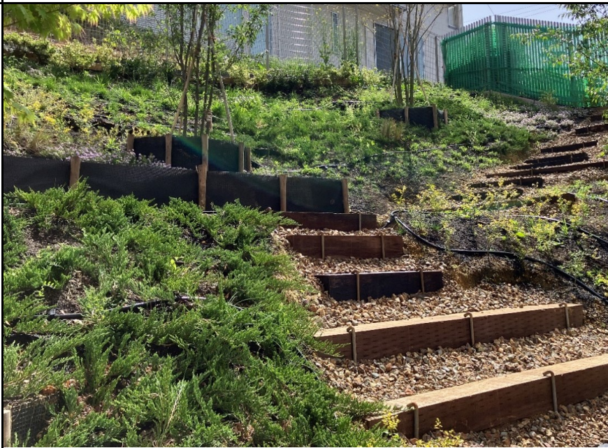
写真4（法面保護と維持管理を兼ねた枕木管理道）
