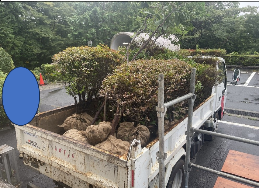
当初は伐採対象でした。 写真3 (既存樹木掘り取り状況)
