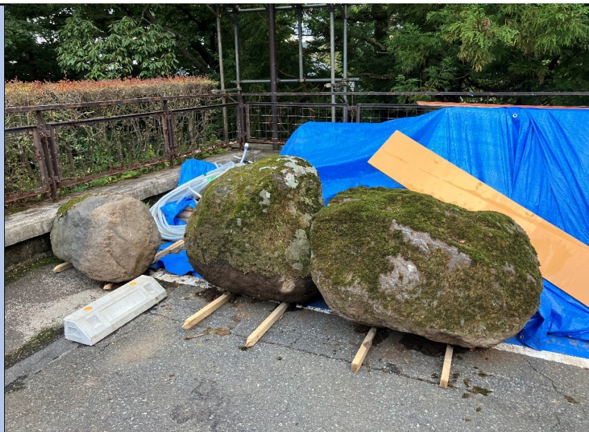
現地発生石(再利用) 写真2 (コケを損傷させないように楊重)
